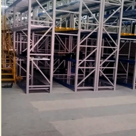
BODEGA CON MEZZANINE
